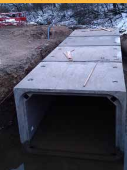
Dérivation des eaux sous voies ferrées
