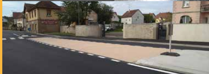
Bordures coulées croisement Brocéliande
