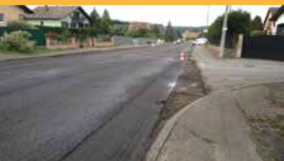
Décroûtage chaussée rue de Belfort
