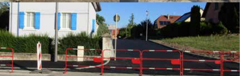
Travaux rue des Bleuets
